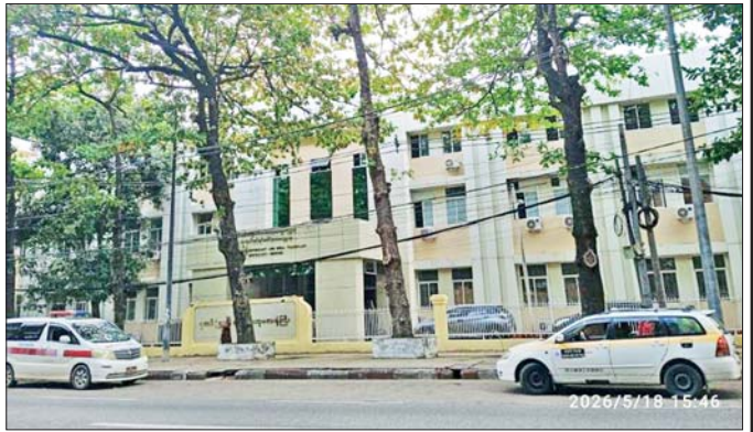
ခုတင်(၅၀၀)အထူးကုဆေးရုံကြီး
